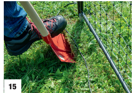
Eingraben des Erdkabels. Achtung: Erdkabel in einem Schutzrohr verlegen Burying the underground cable. Attention: Lay the underground cable in a protective tube Enfouissez le câble souterrain. Attention : Posez le câble souterrain dans une gaine de protection
